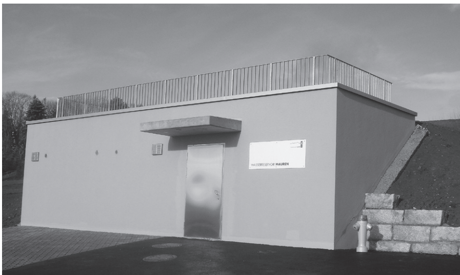
Neues Reservoir Mauren
