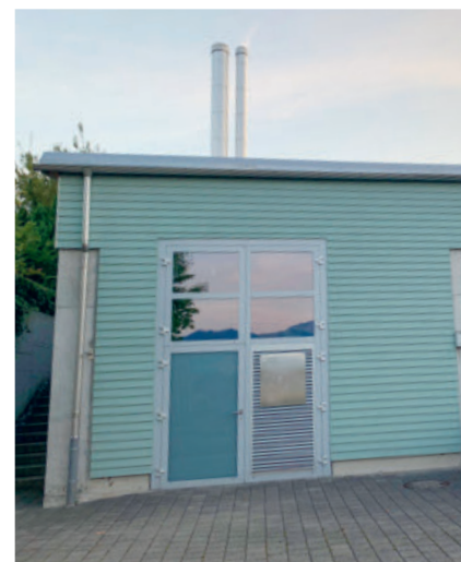
■ Holzheizkraftwerk der gowak AG in Gommiswald.
