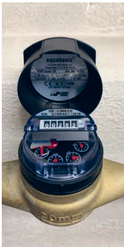
■ Mit der Wasseruhr wird der jährliche Verbrauch gemessen.
