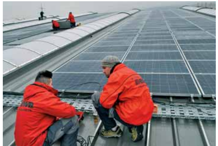
Arbeitseinsatz des EWB-Teams bei der Fotovoltaikanlage, im Vordergrund der Leiter der Elektroinstallationsabteilung Daniel Koller (im Bild rechts) mit unserem Lernenden Philip Cassella.
