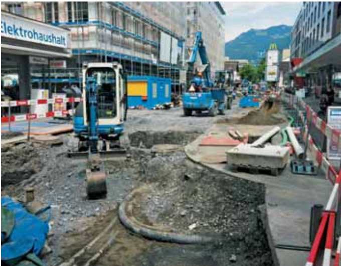
Im Bereich der Überbauungen Blickpunkt und Vögele wurden die Strassenbeläge vollständig neu eingebracht: Baustelle für die Instandstellung der Bahnhofstrasse.
