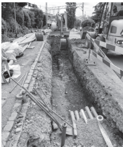
Graben für Hydrantenleitung und EW-Rohre in der Bohlstrasse
