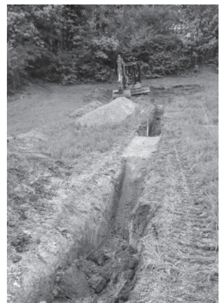
Grabenaushub für neue Leitungen ab Reservoir Buchwald
