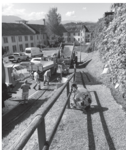
Erneuerung Schottertränke beim Altersheimweg
