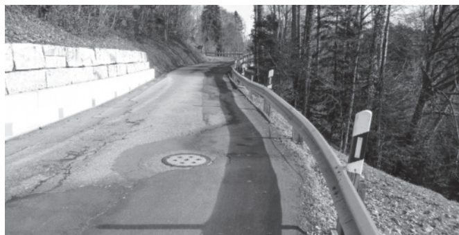
Ernetschwilerstrasse mit bergseitig bereits erstellter Stützmauer. Verbreiterung, Stützmauer talseitig und Belagssanierung sind 2022 geplant.
