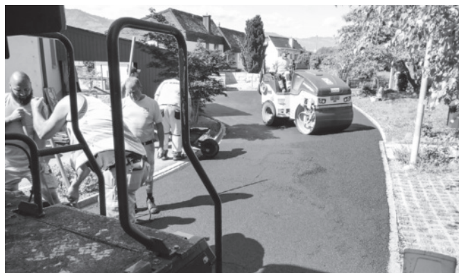
Belagsarbeiten am Tönierweg
