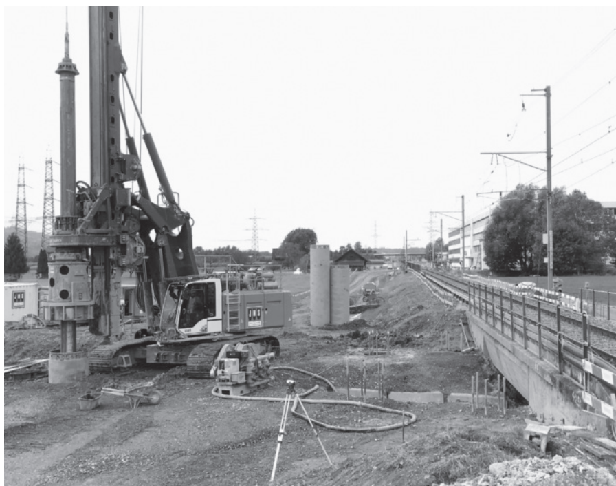
Neue Linthparkweg-Brücke für Doppelspurausbau SBB
