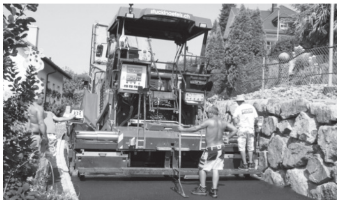
Deckbelagseinbau am Hegnerrain
