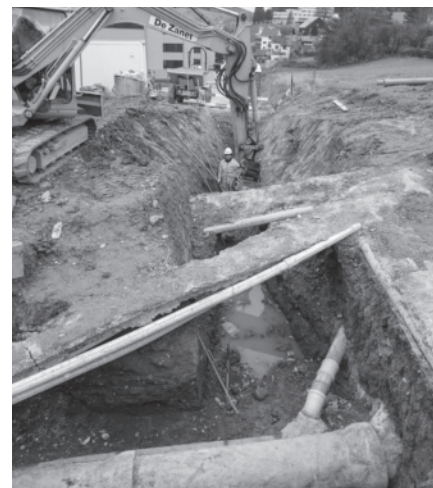
Grabenaushub am Seeblickweg für Neuordnung der Abwasserstränge im Trennsystem
