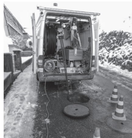
Vorbereitende Arbeiten (Kanal-TV) für Inliner-Sanierung an der Alten Uznabergstrasse
