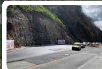
Rotonda Strada cantonale
