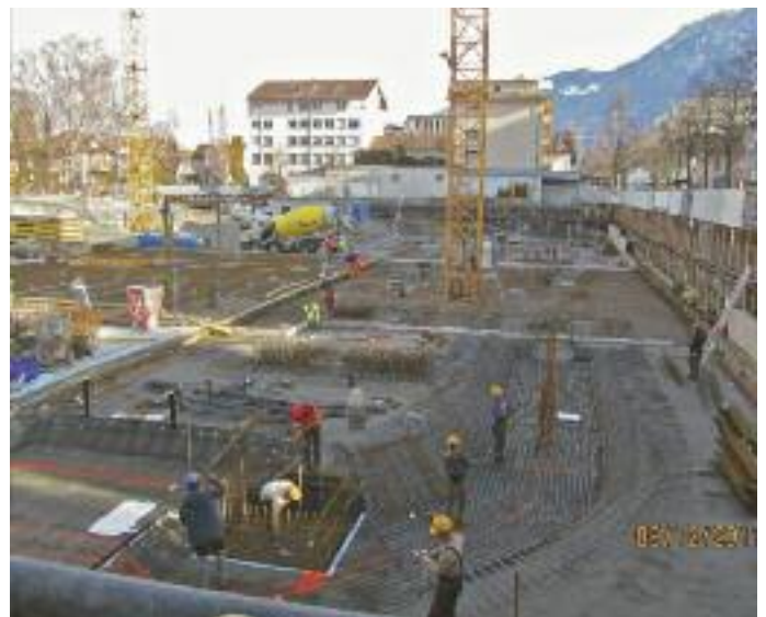
Die Baustelle der Grossüberbauung «Blickpunkt».
