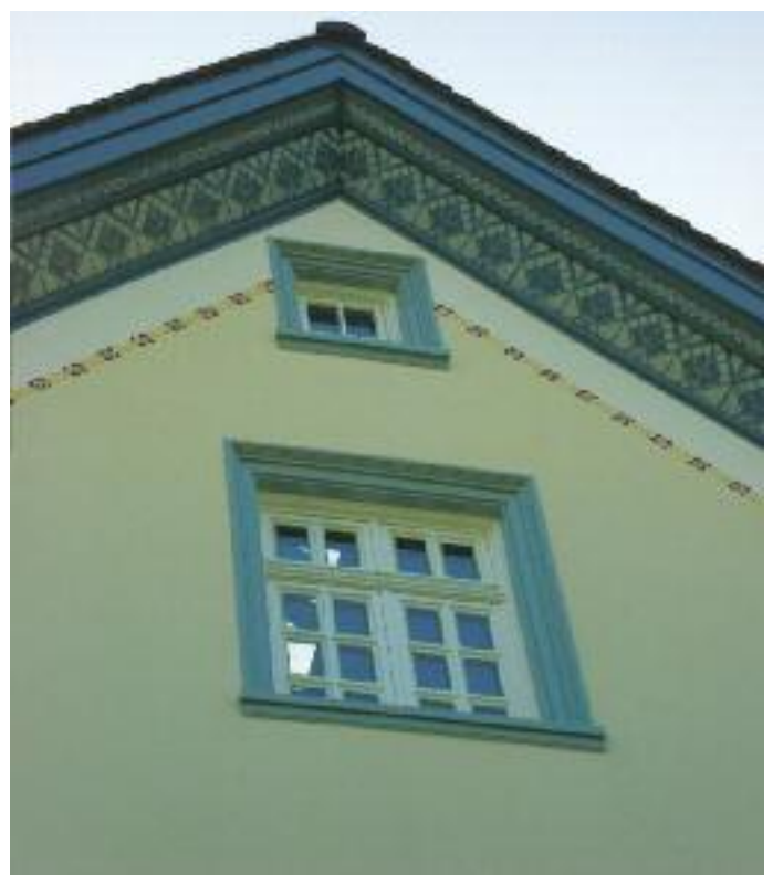
Sanierung der Fassade der Gemeindebibliothek.
