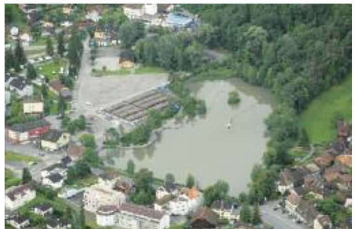
Baustelle Werdenbergersee während der Sanierung.
