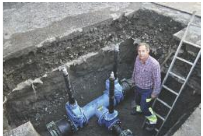
Der Brunnenmeister René Bütler installiert eine neue Wasserleitung an der Fabrikstrasse in Buchs.
