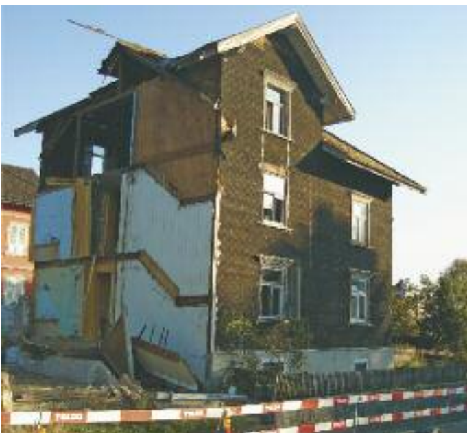
Abbruch Wohnhaus Turnhallenstrasse 2.
