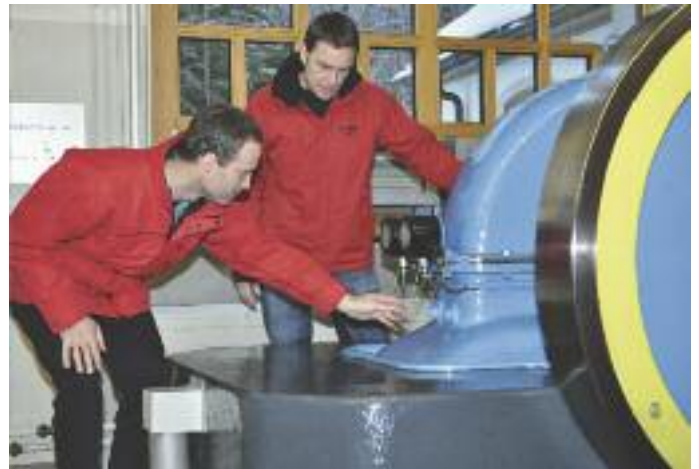
Vor-Ort-Besichtigung der geplanten Anlagenerneuerungen am Kraftwerk Tobeläckerli. Der Leiter der Wasser- und Stromversorgung, Jürg Göldi (links), mit dem Verantwortlichen für den Anlagen- und Netzbetrieb, Niklaus Müller.
