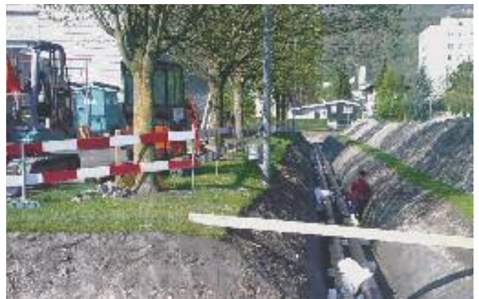
Verlegung der Fernwärmeleitung beim Oberstufenzentrum Flös.
