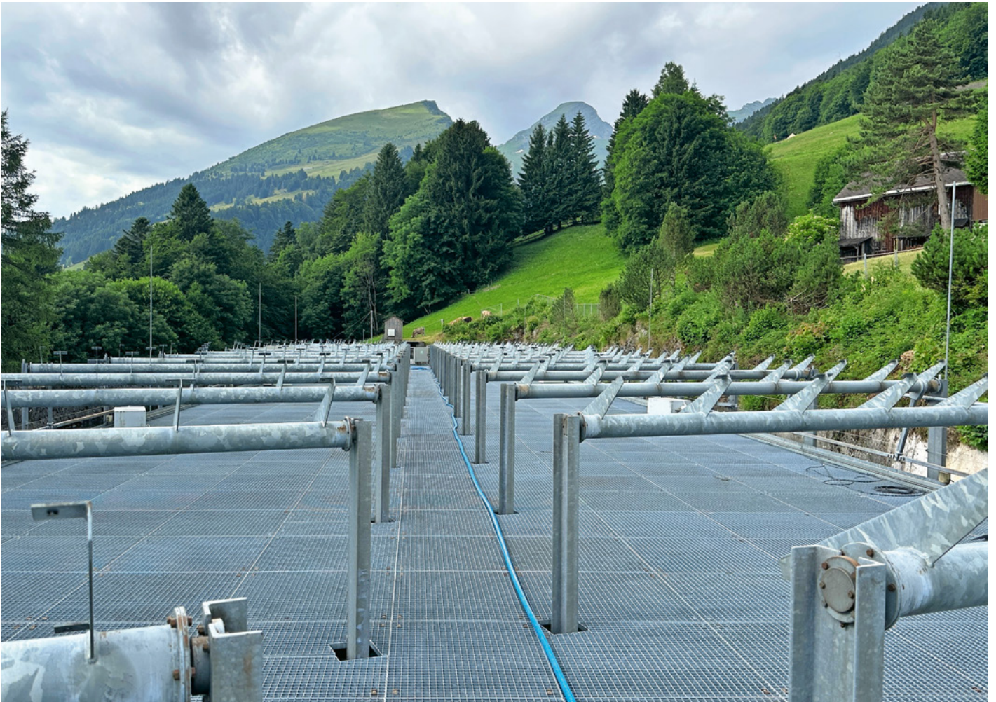
Ausgleichsweiher Vorderberg: Die PV-Module aus dem Jahr 1998 sind entfernt und werden durch neue ersetzt.
