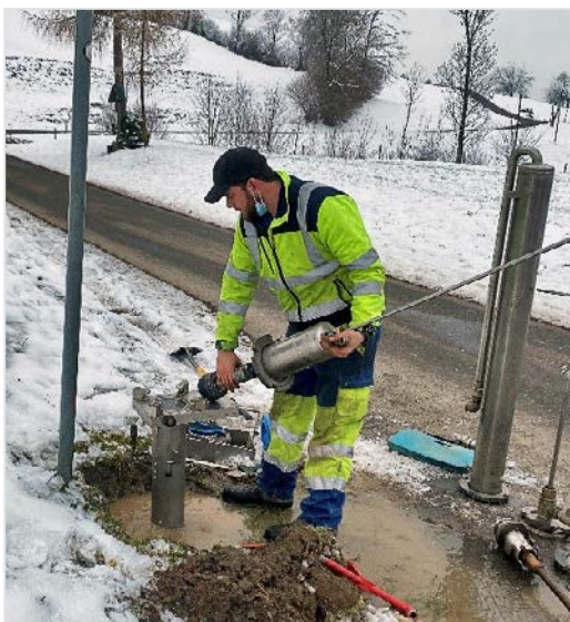
Marco Bieri, Revision eines Hydranten
