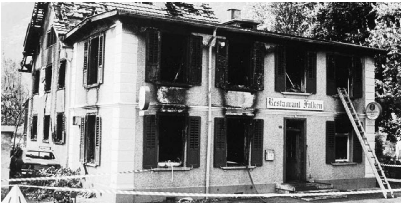
Das Restaurant Falken wurde in der Nacht vom 11. auf den 12. Mai 1987 durch Brand zerstört.
