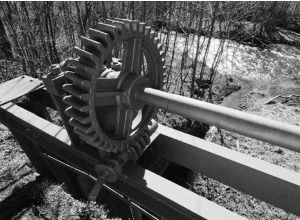
Der Bau des Werdenberger Binnenkanals war ein Jahrhundertwerk.
