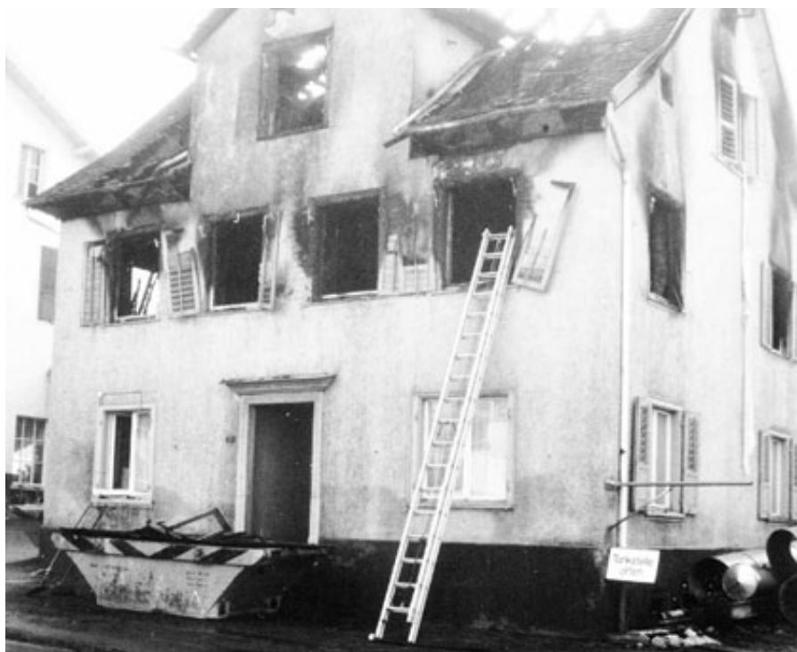
Wohnhausbrand am 10. Januar 1971, an der Hauswand rechts sind noch die zusammengeknüpften Leintücher zu sehen.
