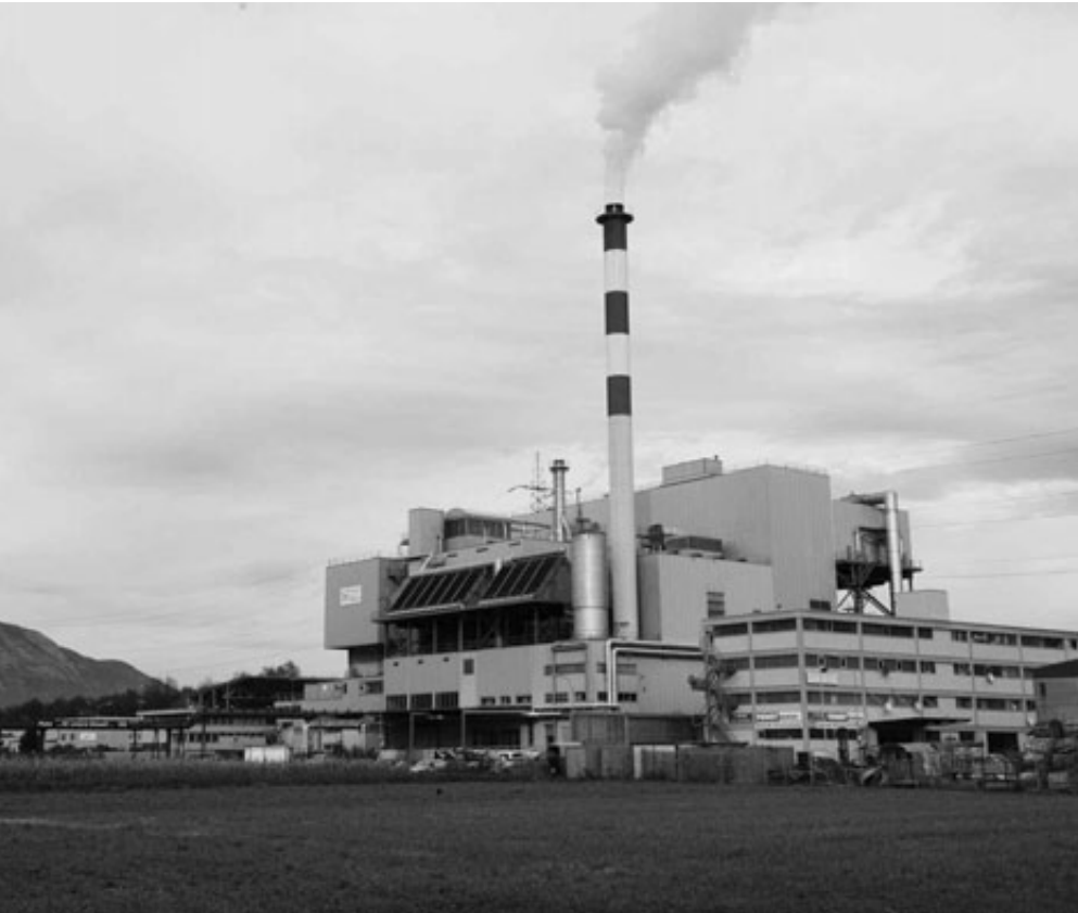
Wärme aus Abfallverbrennung: Dank der Kehrichtverbrennungsanlage verfügt Buchs über ein noch immer wachsendes Fernwärmenetz.
