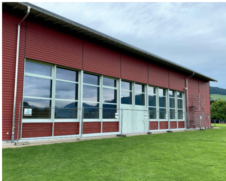
Neue Fensterfront bei der Mehrzweckhalle Ernetschwil
