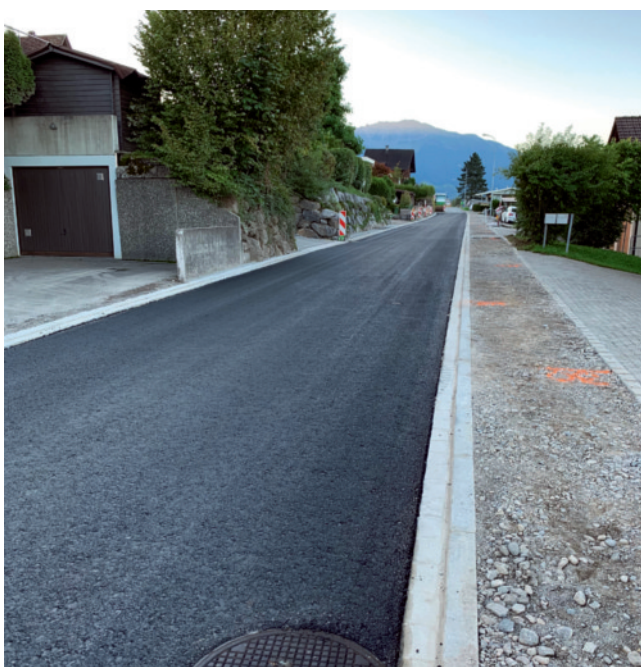
In Gommiswald werden diverse Strassen saniert
