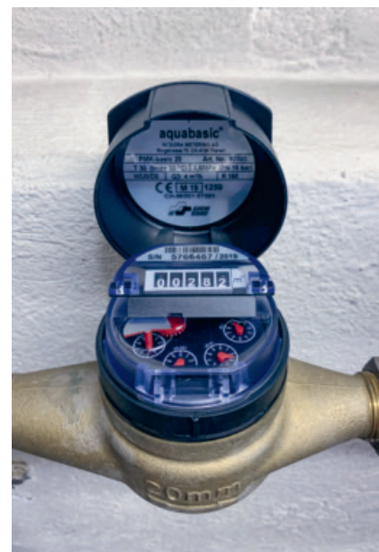
■ Einige Wasseruhren werden ersetzt.
