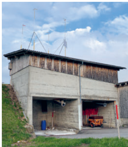
■ Das Salzdepot wird saniert und in einer Kammer ein Silo eingebaut.
