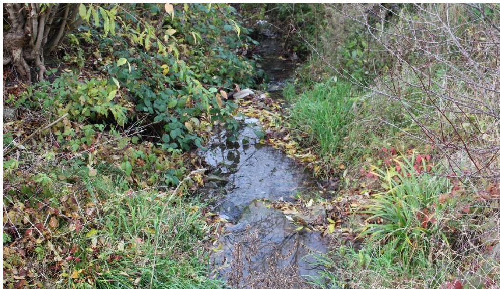
Abbildung 51: Abschnitt des Haslibachs innerhalb des Siedlungsgebiets
