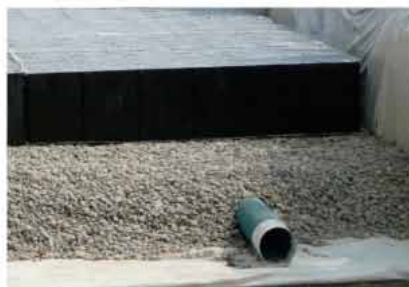
Circulation de l'eau dans les blocs : autocurage de la structure
