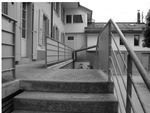
Barrière de sécurité « renforcée » à l'arrière du bâtiment communal et pose d'éléments de sécurité pour les bacs à fleurs à ses fenêtres, aux étages.
