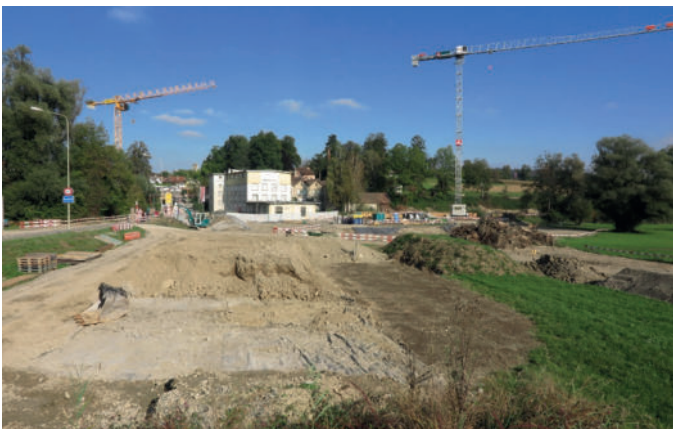
Die Grossbaustelle während dem Bau am 10.10.2021. Im Hintergrund das Haas-Areal. Foto: Josef Fischer
