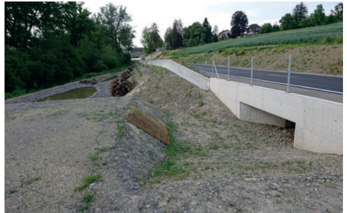
Neue Weiher für den Laubfrosch oberhalb des Haas-Kanals und das Leitsystem entlang, sowie ein Kleintierdurchlass unter der neuen Strasse hindurch. Foto: Niklaus Peyer
