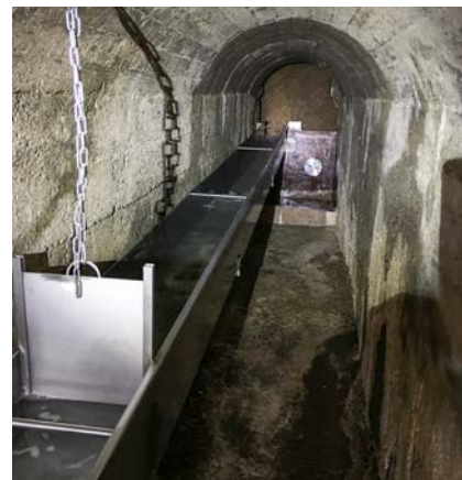
■ Quelfassung Marxen in Rieden
