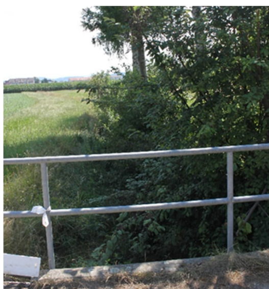
Abb. 9: Unterquerung Strasse bei der Feldmatt
