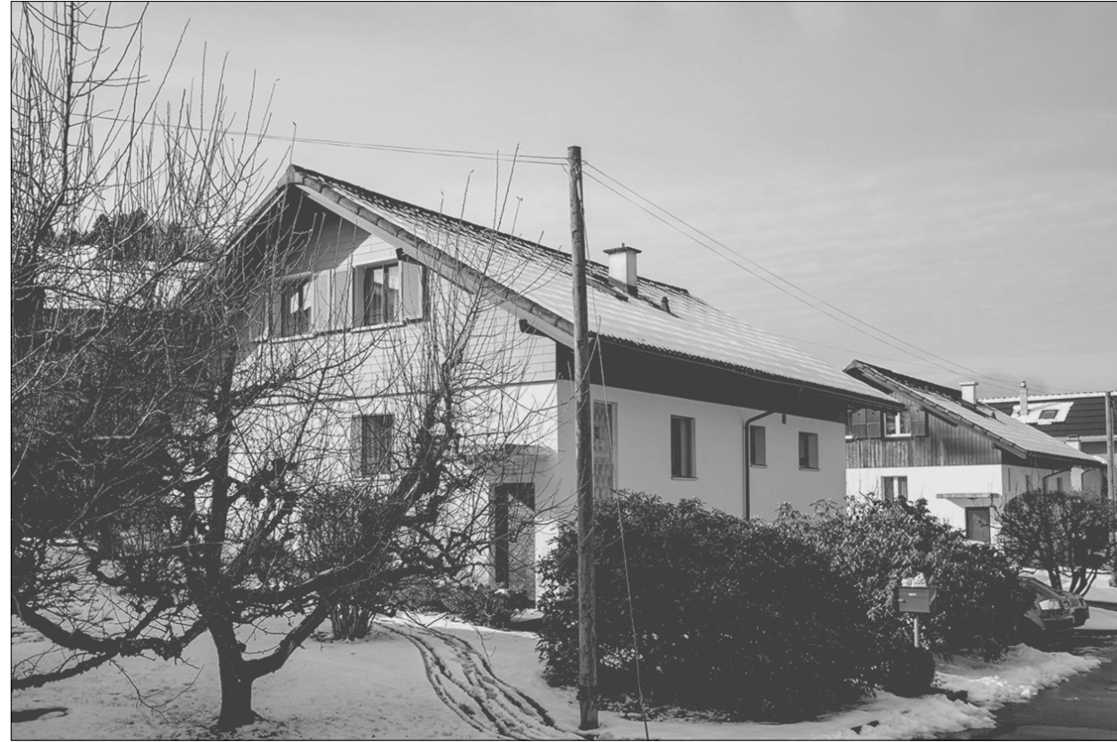
Fassadenansicht Nord & Ost I 26.02.2023
