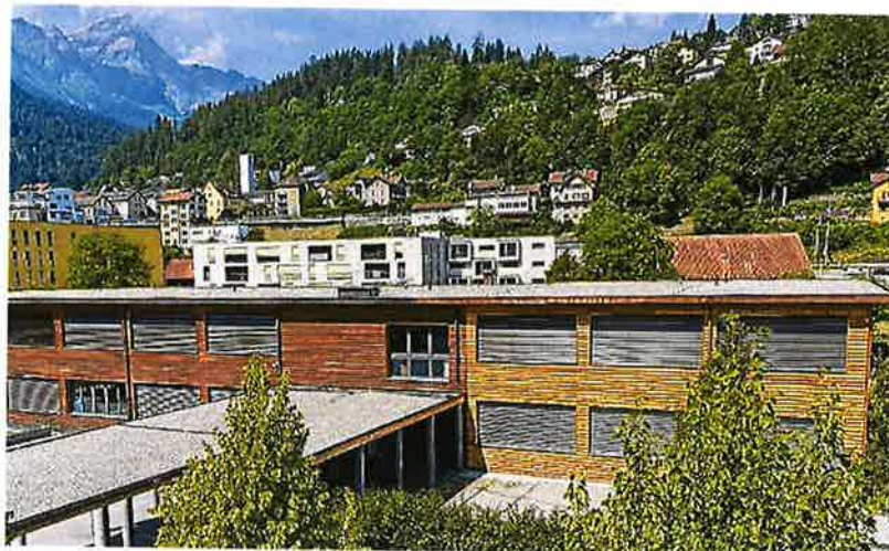
Die Fassade des Schulhauses Compogna ist mit Lärchenholz aus Thusner Wäldern verkleidet. Der hellere Teil rechts ist der fertige Anbau, welcher zum neuen Schuljahr eröffnet wird.
