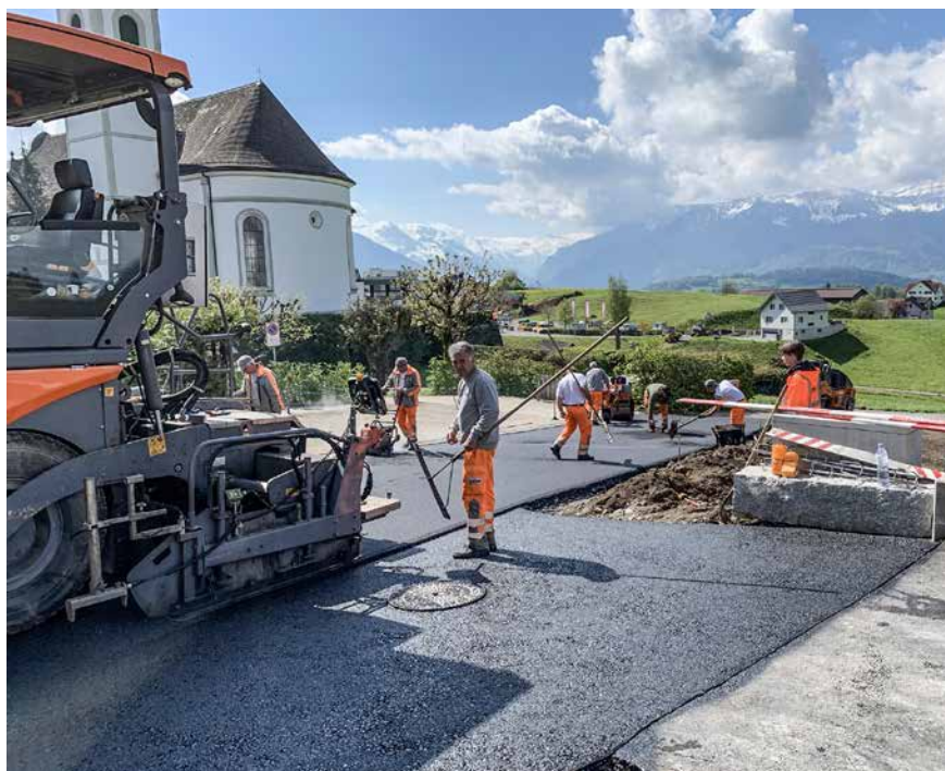
■ Der neue Strassenbelag wird eingebracht.
