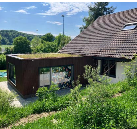
Der neue Anbau beim Kindergarten Dinhard passt bestens zum bestehenden Gebäude.
