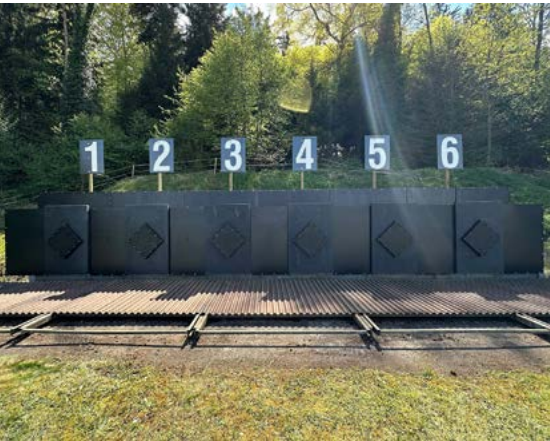
Blick auf den umgebauten Zielhang.
