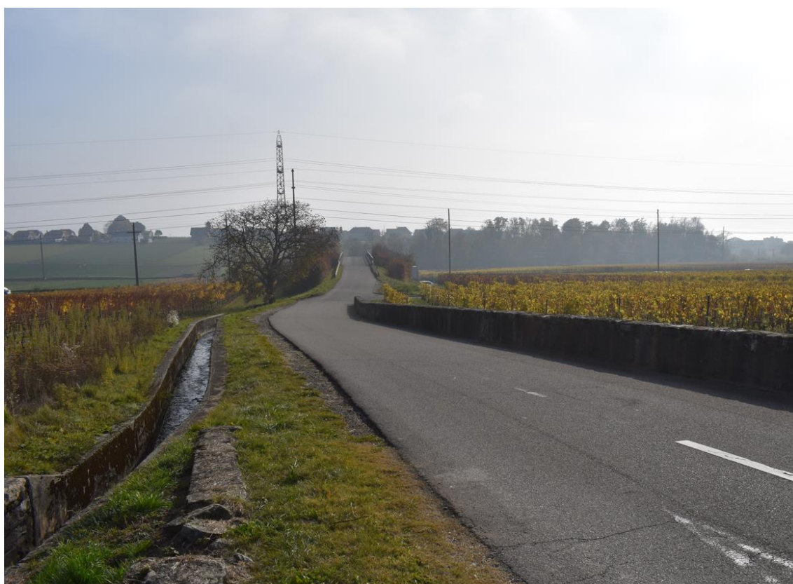
Figure 8: Vue de la route de Bougy, côté Jura (Surveillance de l'ouvrage du 27 octobre 2022)
