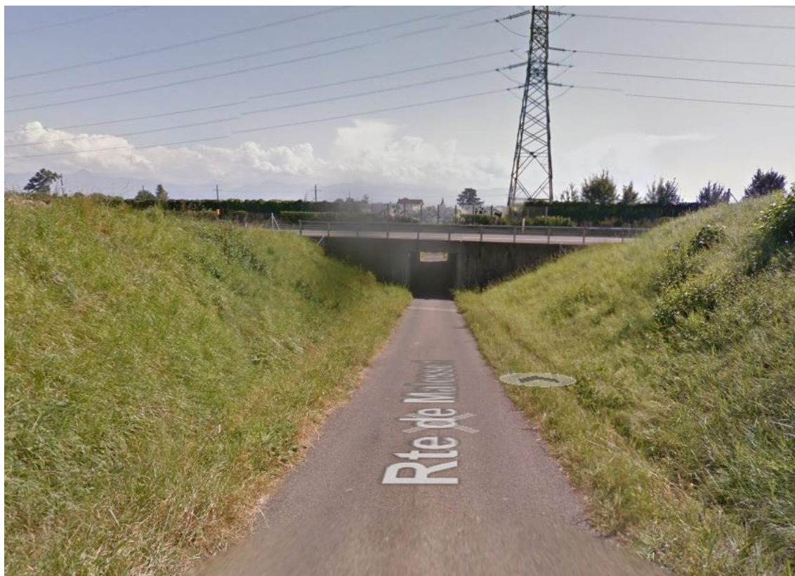
Figure 15: Déviation piétons et cyclistes sur la route de Malessert (Source : Street view - GoogleMaps - consultation le 20 mars 2023)
