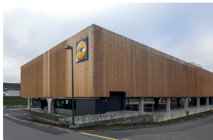
Beispiel für Parkierung im Sockelgeschoss, Dättwil (AG).
