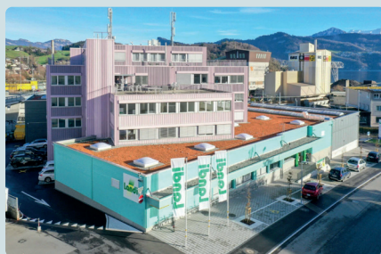
Beispiel Anbau an bestehendes Gewerbegebäude, Horw (LU).
