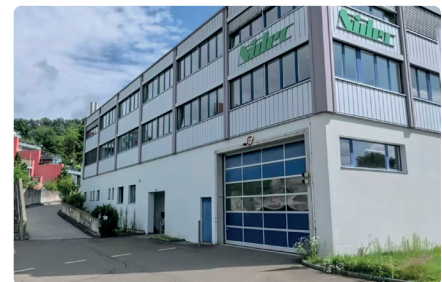
Beispiel für mehrgeschossige Produktion mit Rampe für das 1. Obergeschoss, Birmenstorf (AG).
