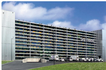
Beispiel für Wärmeschutz: Aussenverschattung mit Brise-Soleil-Lamellen, Fassadenbegrünung und helle Farbe.
