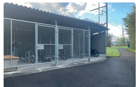
Beispiel wettergeschützte Abstellplätze, Arbeitszone Sins.
