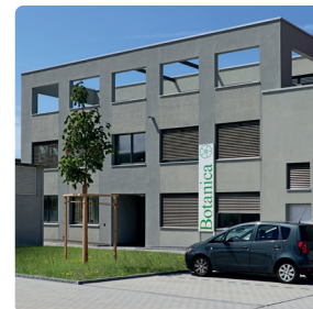
Beispiel für Wärmeschutz: Würfelähnliches Gebäudevolumen mit kleiner Hüllfläche, kühlende Dachbegrünung und aussenliegende Fenster Verschattung, Arbeitszone Sins.
