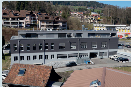
Beispiel für die Erschliessung von zwei Produktionsebenen mit dem natürlichen Geländeverlauf, Adligenswil (LU)
