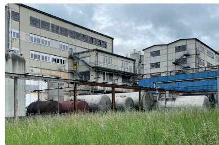
Impression Altbauten Nr. 817 und 832: Grosser Massstab, Rasterfassaden, Aussentreppen und Transportanlagen.
