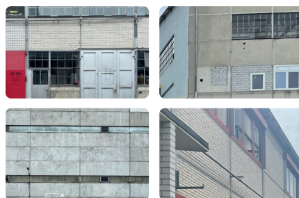
Industrieller Ursprungscharakter der Arbeitszone.
