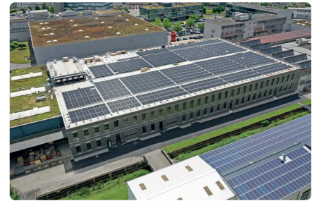
Beispiel für Solar- und Gründächer, Aarburg (AG).
