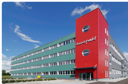
Beispiel für mehrgeschossige Produktion mit Warenlift, Dintikon (ZH).
