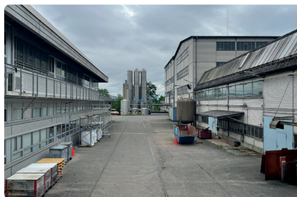
Impression Altbauten Nr. 880, 949 und neueres Gebäude Nr. 1432: Anordnung der Gebäude im Raster.
