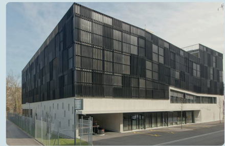
Beispiel für die Kombination von Produktionsflächen im Erdgeschoss mit Parkhaus in den Obergeschossen, Zürich
