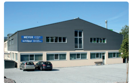
Beispiel für Wachstum in die Höhe: Aufstockung mit zweiter Produktionsebene und Warenlift, Wohlen (AG).
