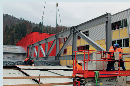
Beispiel Aufstockung einer Industriehalle mit grossen Spannweiten, Werthenstein (LU).
