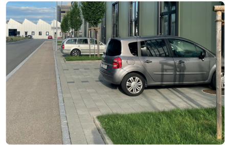
Beispiel für Wärmeschutz: Sickersteine, helle Beläge, Grünflächen und Bäume, Wädenswil (ZH).
