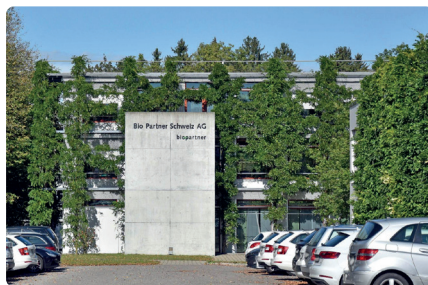
Beispiel für Fassadenbegrünung in Industriegebiet, Seon (AG).
