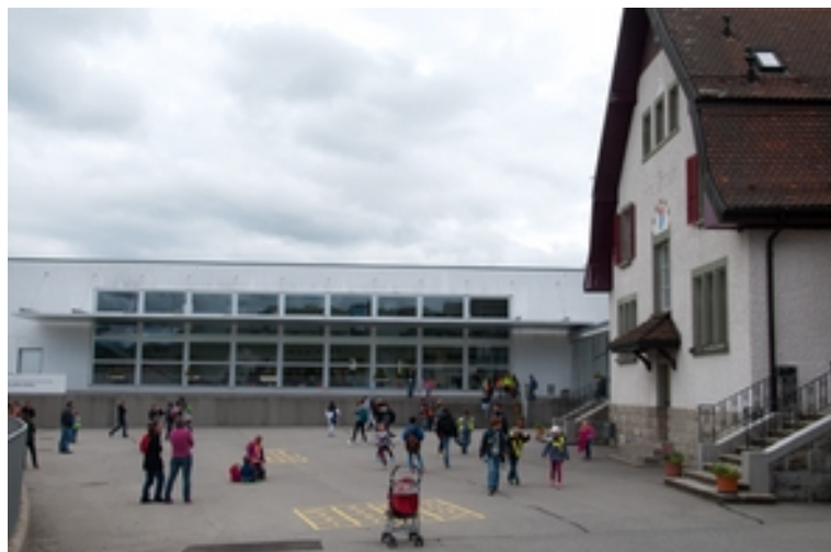
Sortie de classes à l'école communale, ancien et nouveau bâtiments.
