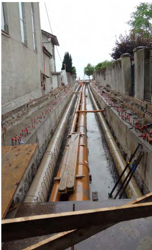
Ruelle des Halles
