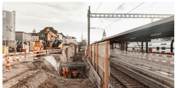
Die Erweiterung der SBB-Personenunterführung erforderte von den Anwohnenden und Pendelnden viel Geduld.
