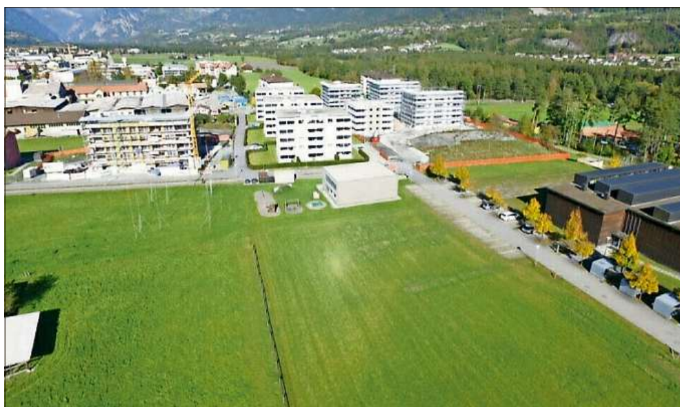
Standort der neuen Schulanlage Compogna, im Hintergrund die rege Bautätigkeit.
