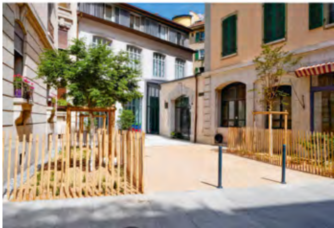
Le SEVE a remplacé 140 m 2 de goudron par de la matière argilo-calcaire, de la verdure et du béton balayé.
