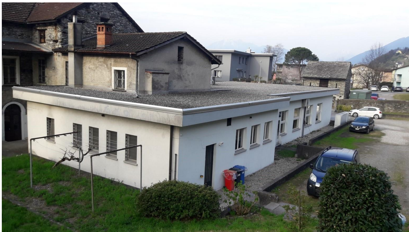
Facciate est e nord
