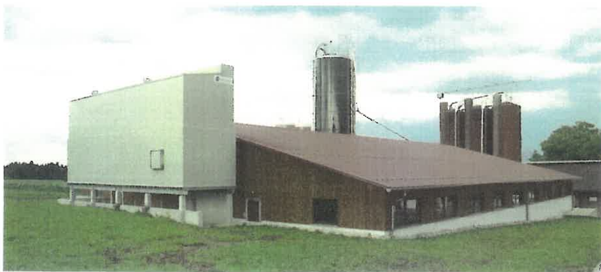
Abbildung 2: Biowäscher mit Vorreinigung und Tropfenabscheider (Bild Huber Kontech AG).
