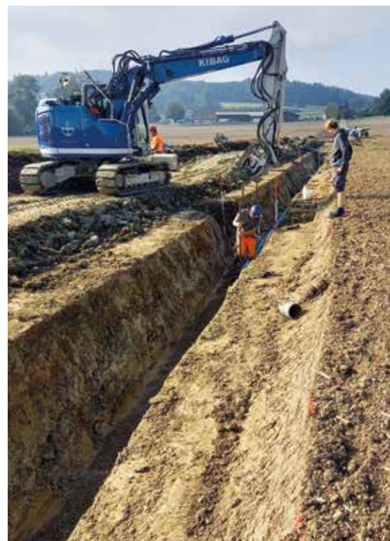
Bauarbeiten Ersatz Überlandleitung Lindenhof bis Buck.
