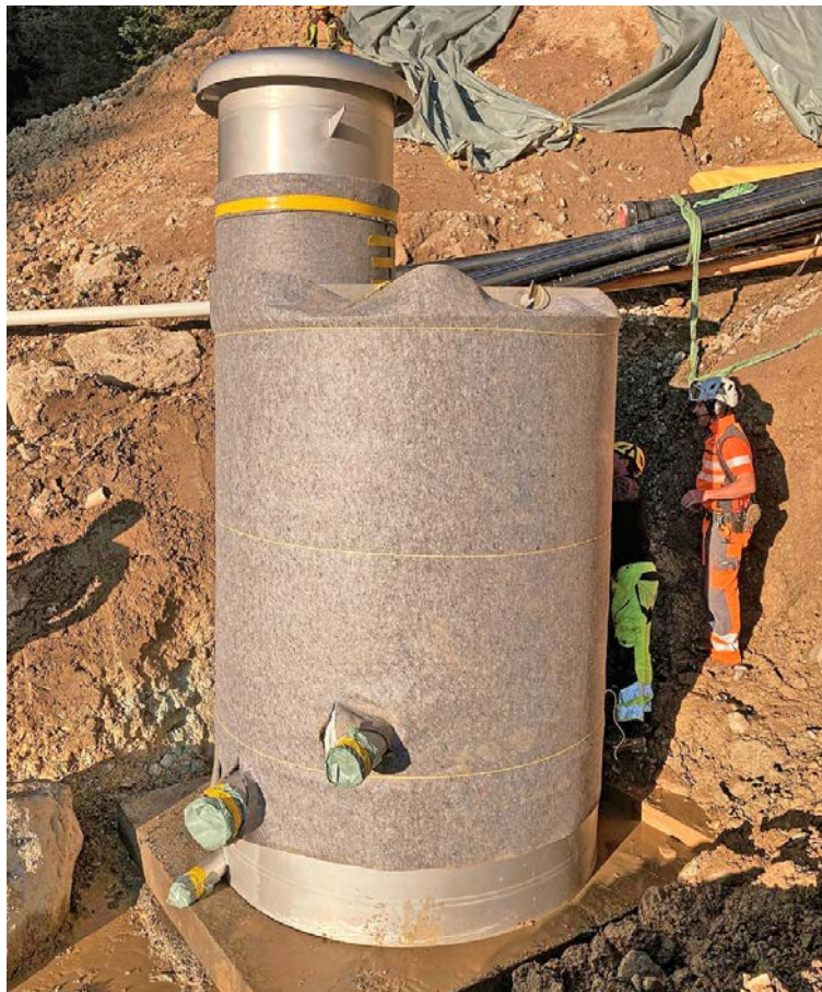
2022 wurde in Obermuttten ein Reservoir erneuert. Es fasst 200 Kubikmeter Löschreserve und 50 Kubikmeter Brauchreserve Wasser und wird von mehreren Quellen rund um das Muttner Horn gespeist.
