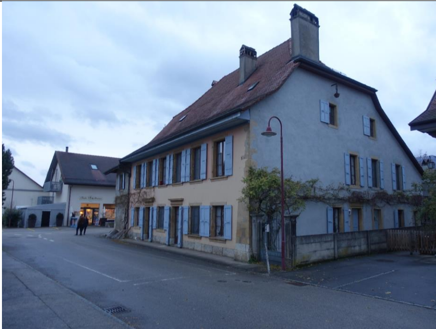
Centre du village: bâtiment large et cossu (trois fenêtres par étage au minimum sur rue) de deux niveaux, isolé. Teintes neutres des façades : beige ou gris. Fenêtres verticales avec des volets colorés.
