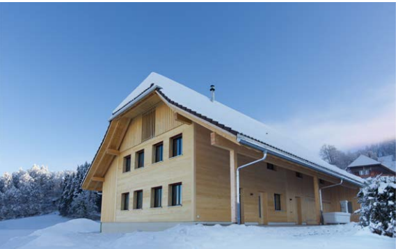
Der Neubau «Härlihaus» in Luthern. Zu diesem ersten Vollholzhaus im Luzerner Hinterland hat die Birrer Schreinerei Holzbau AG die ganze Bandbreite ihres Handwerks beigesteuert. Fotos David Koller
