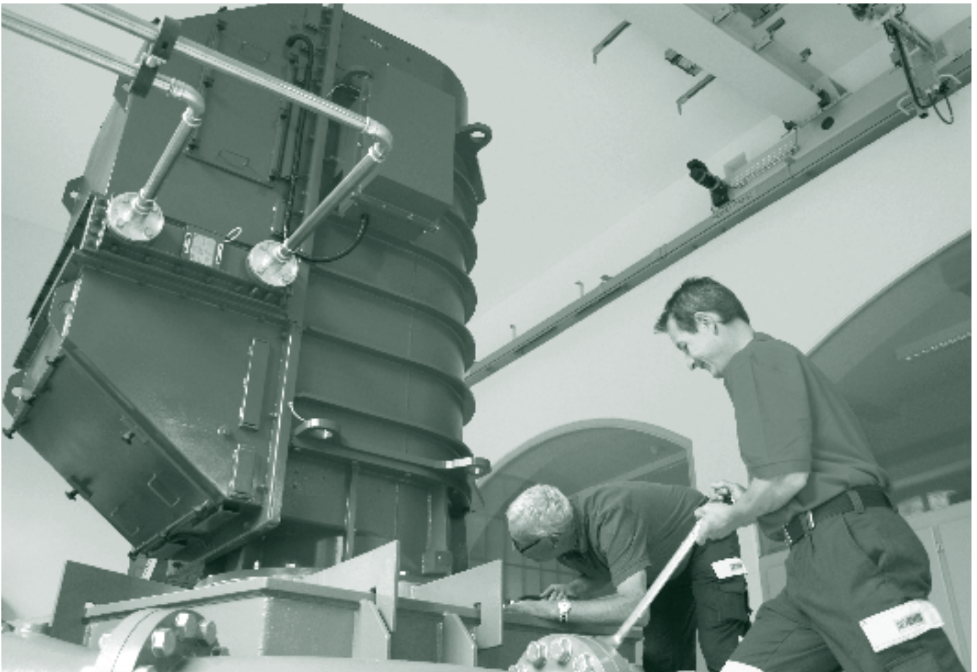
Mitarbeitende aus dem Bereich Wasser- und Stromversorgung, Heinz Rothenberger (links) und Hannes Forrer, bei Wartungsarbeiten am neuen Trinkwasser - Kraftwerk Tobeläckerli
