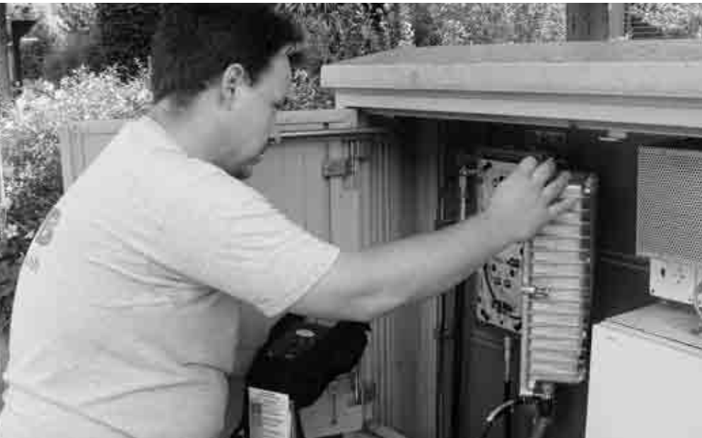
Messtechniker Hermann Schneider führt eine Signalqualitätskontrolle an einem Netzverstärker durch.
