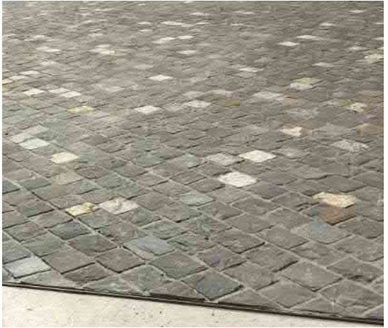
Natursteinpflasterung, Identitätstiftender Bodenbelag des Dorfkerns
