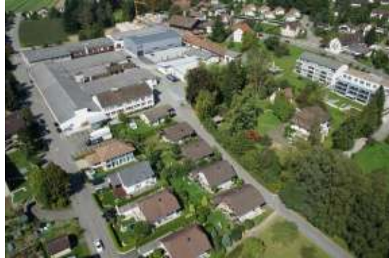
Tuboly-Areal der Arbeitszone A1
