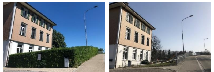
Kindergarten an der Gossauerstrasse vor und nach Rodung der Hecke zur besseren Übersicht und Erhöhung der Verkehrssicherheit
