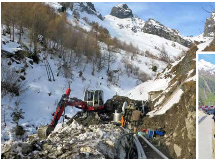
Assainissement des captages de Saille à Ovronnaz
