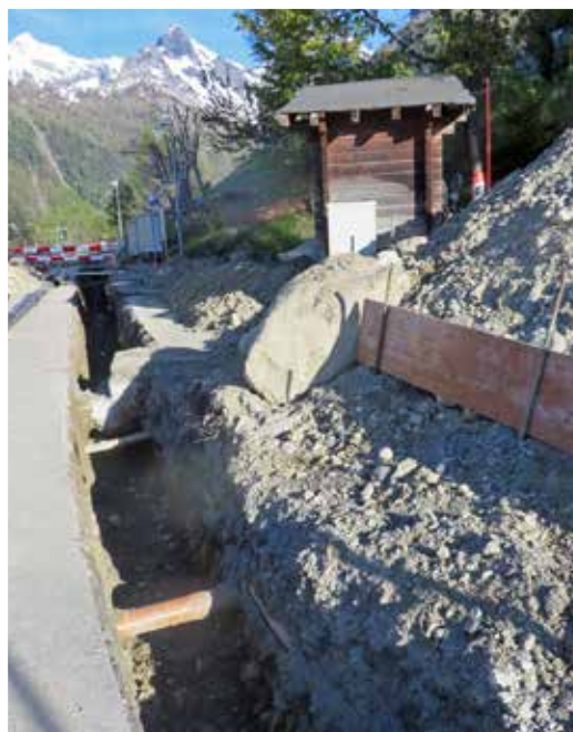
Remplacement de canalisations à Ovronnaz
