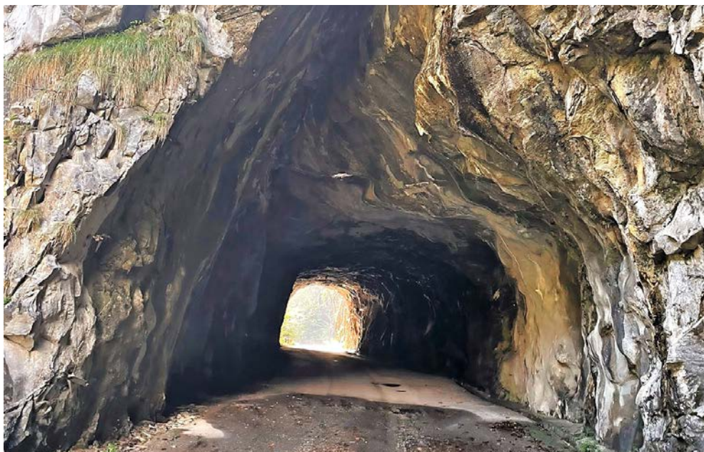
Auf gutem Weg: Das historische Teilstück der Commercialstrasse, das «Verlorna Loch», soll über ein Fundraising umfassend saniert und besser in die touristischen Angebote der Region integriert werden.
