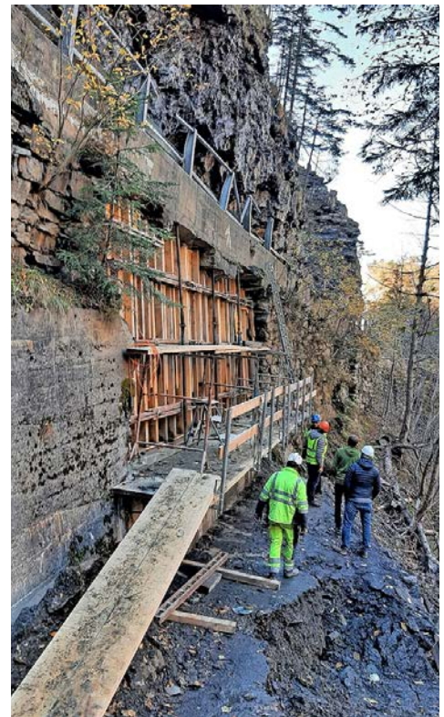
Aufwendige Mauersanierung, abgeschlossen im Jahr 2022. Bilder zVg
