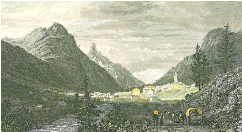
Auf der Commercialstrasse Richtung Splügen unterwegs.
