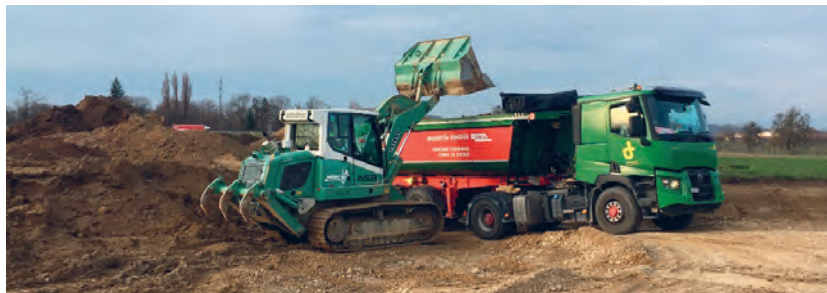
Der Baustart für den Fachmarkt Ebnet ist im vergangenen Monat erfolgt. Eröffnet wird das Center voraussichtlich im Sommer 2021.
