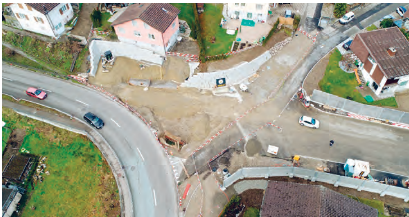
Der extrem schwierige geologische Untergrund des Hanges im Knoten Winterthurerstrasse/Rosenbergstrasse führte zu einer Bauverzögerung von zwei Wochen.
