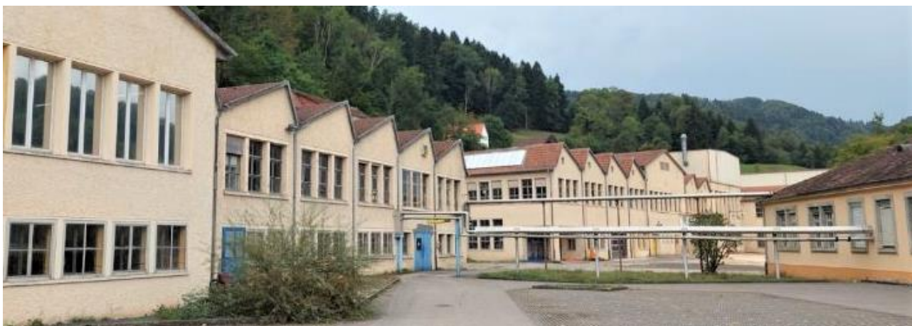
Figure 13 : Vue sur les bâtiments du site Thécla à St-Ursanne
