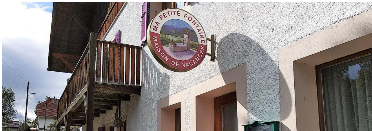
Figure 27 : Vue sur une maison de vacances au milieu du village de Seleute
