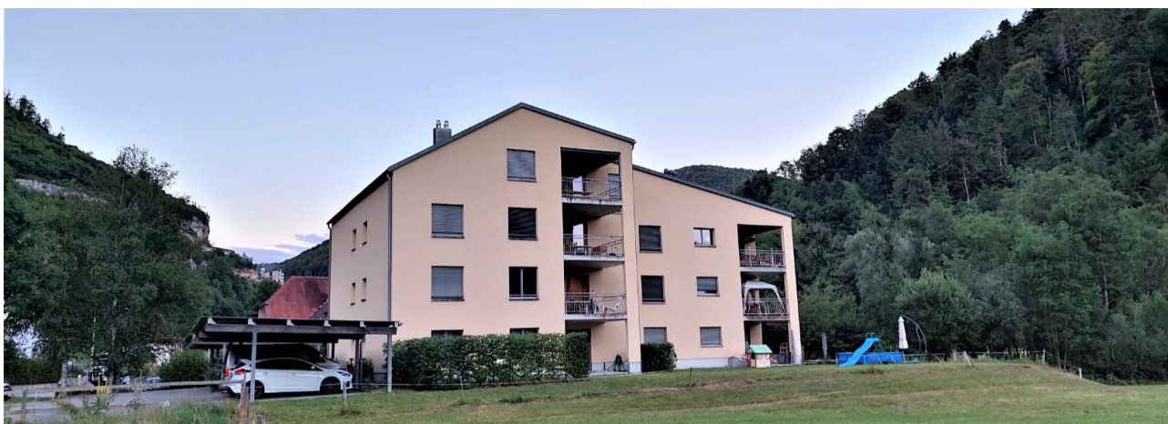
Figure 12 : Vue sur l'immeuble du Pré L'Abbé à St-Ursanne
