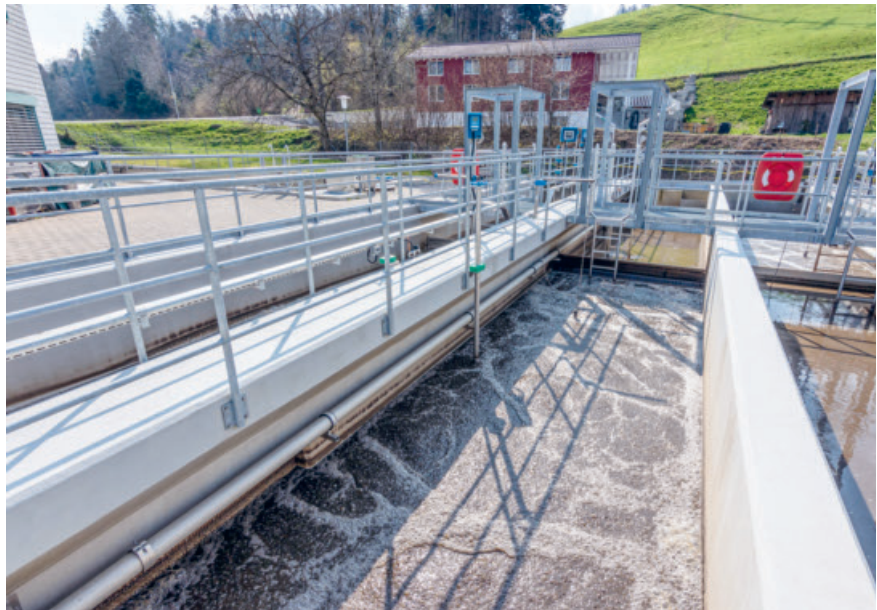
■ Die ARA Eschenbach wurde ausgebaut und saniert.
