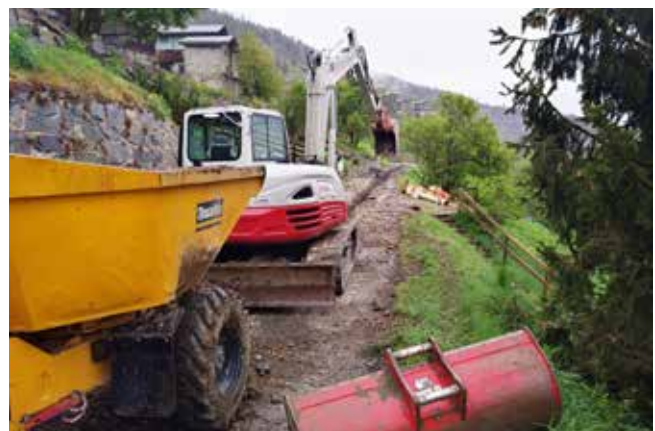
Schwieriger und aufwendiger als erwartet I: Der Bau der Oberflächenwasserleitung auf der Tschingerestrasse unter dem Dorf.
