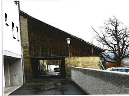
Durchfahrt Stallstrasse von Süden
