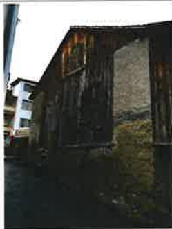
Ansicht von Südosten
