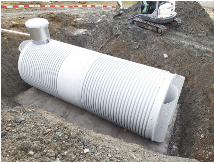
Ausgleichsbecken (die Fotos zeigen das 2021 in Val Ruschna, Scuol, installierte Becken)
