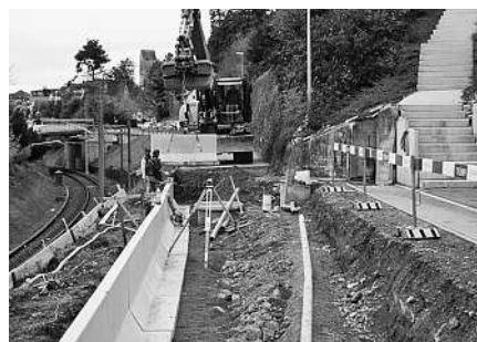
Versetzen der Winkелеlemente entlang der Bahnlinie.
