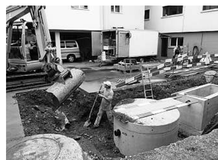
Erstellung der Spezialschächte.
