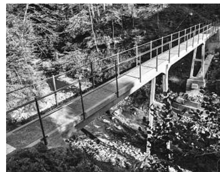
Hebeltobelbrücke während und nach der Sanierung.
