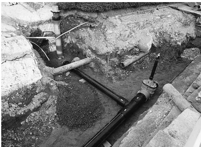
Werkleitungsbau entlang der Mühlaustrasse.
