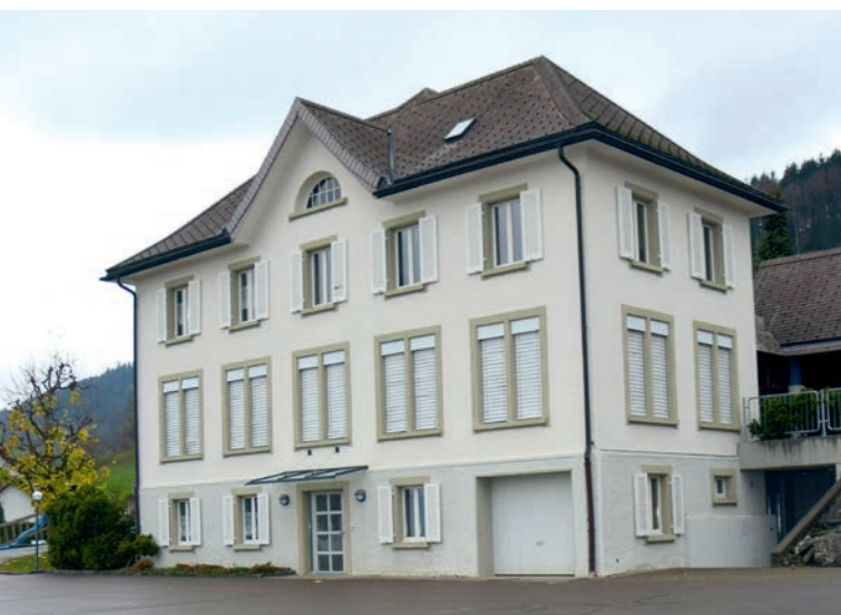
Das ehemalige Schulhaus Gebertingen steht seit dem Sommer 2019 leer.
