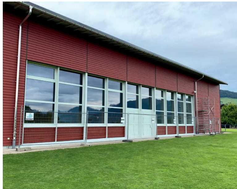
Neue Fensterfront bei der Mehrzweckhalle Ernetschwil
