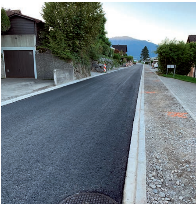
In Gommiswald werden diverse Strassen saniert
